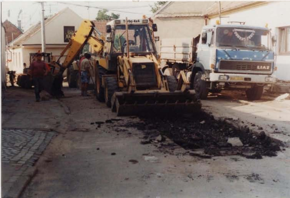
PRÁCE V ULICI OBCHOVNÍ
