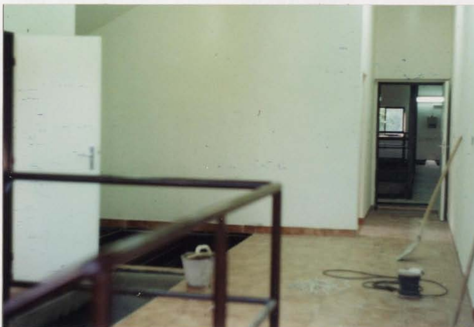
DOKONČOVACÍ PRÁCE UVNITŘ ČOV
