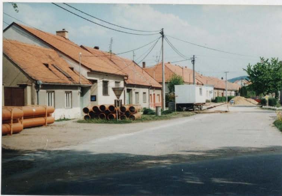
SKLÁDKA MATERIÁLU U KOSTELA
