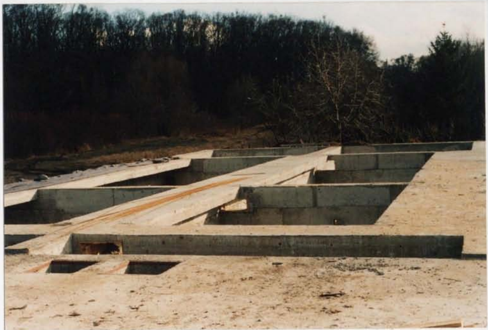
VÝSTAVBA ČOV UKONČENÍ SPODNÍ STAVBY
