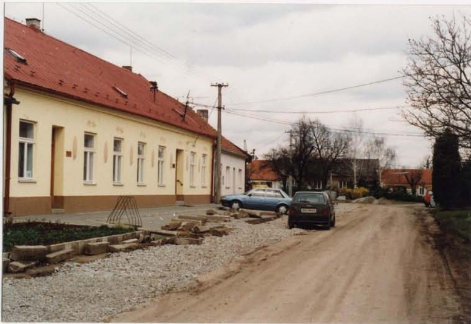
POLOŽENÁ KANALIZACE U FLORIÁNKA
