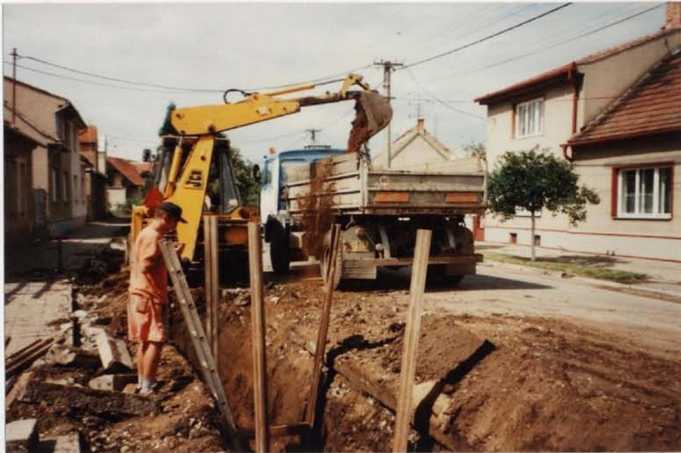
ULICE ŠKOLNÍ VÝKOP
