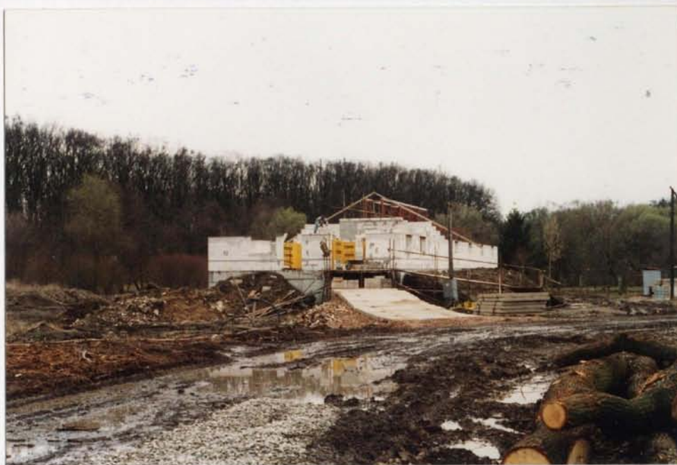
VÝSTAVBA NADZEMNÍ ČÁSTI
