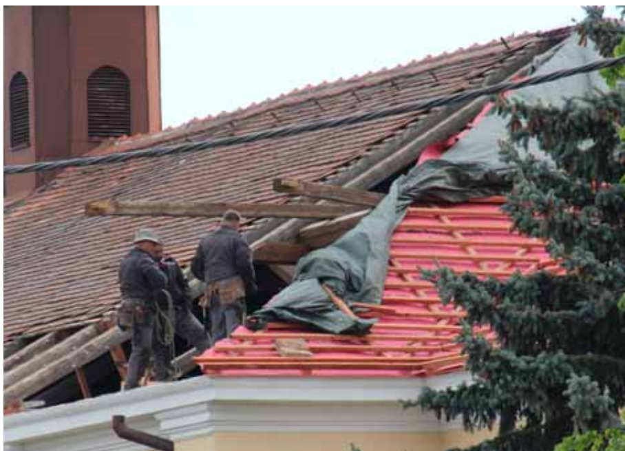
Oprava střechy kostela je v plném proudu
