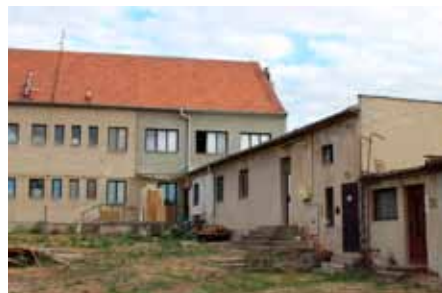
Původní budova Vzdělávacího centra – vnitřní trakt
