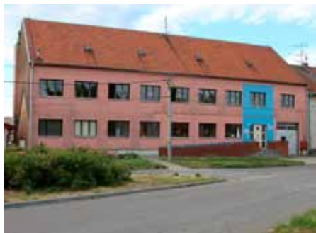
Čelní budova vzdělávacího centra – dřívě
